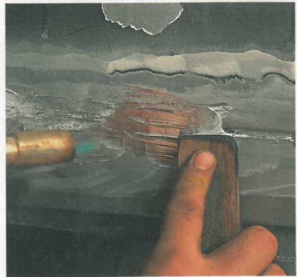
Erst nach dem Vorbehandeln kommt das Zinn von der Stange: Zunächst werden die Stücke verteilt, dann mit einem Hartholzspachtel verschwenmt – sprich: glattgestrichen. Dabei wird das Material mit der Lötlampe heiß gehalten. Vorsicht: Das weiche Zinn nicht in kalte Bereiche ziehen
