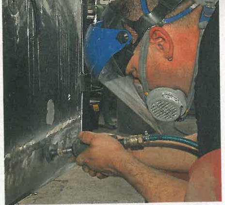
...sich allerdings auch Spuren der Hitze, die beim Zinnen entsteht – es kommt zu Wellen
