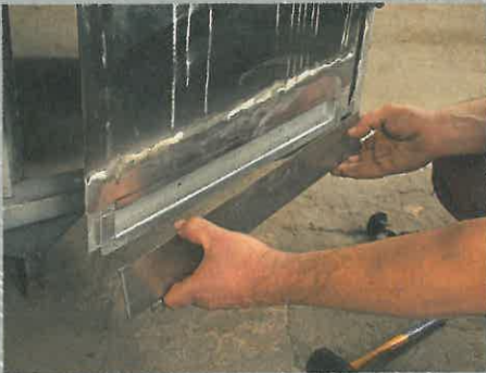
Nun wird das vorverzinnnte Neuteil angeschweißt, die Punkte anschließend verschliffen. Danach pinselet der Fachmann auch diese Nahtstelle noch mal mit Lötpaste ein, um den Schutz zu verbessern
