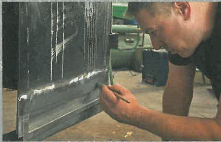
Das durchgerostete Türblech wird durch ein maßgefertigtes Teil ersetzt. Hier soll eine Überlappung entstehen, die Peer Gorgiel schon vorm Schweißen mit Lötpaste vorverzinnt. Dies geschieht nicht nur an der Tür selbst, sondern auch am Reparaturblech – Spenglerarbeit nach Altväter Sitte
