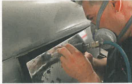
...schnell für Macken. Beim Feinschliff stets Mundschutz tragen – der Staub ist giftig!
