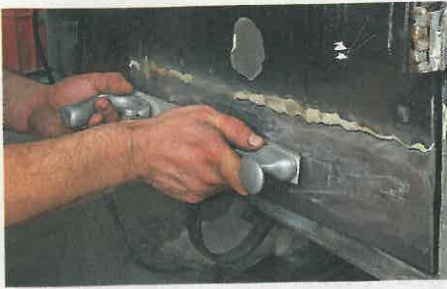
Zur Ausformung der Zinnschicht kommt ein verstellbarer Karosseriehobel zum Einsatz
